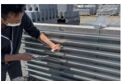
スタートレールと一般レールを下から順序よく縦胴縁に取り付け、最後にトップレールを取り付けます。
