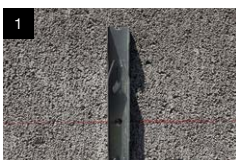
位置を決め、縦胴縁を躯体に取り付けます。
