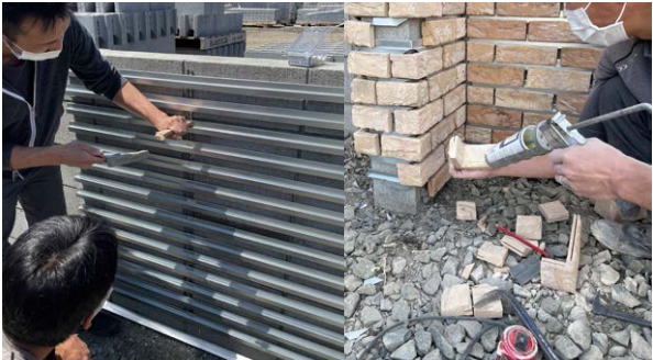
金属レールにスライス加工と溝を施したレンガ、石材をはめ込みます。
